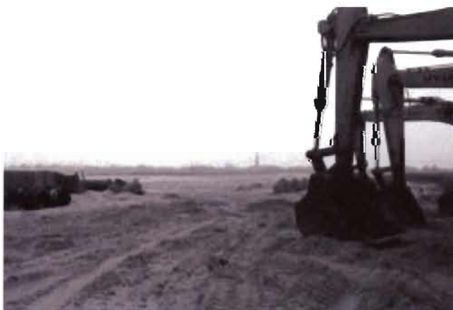
Altenwerder während der Bauphase
